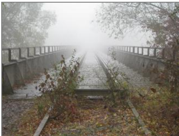
Cestu lemují železniční trať, která dříve vedla do Štramberku. Teď už tu vlaky nejedí
